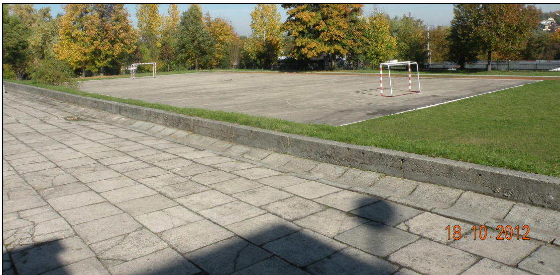
FOT 1. Widok boiska z nawierzchnią asfaltową oraz placu z chodnikowych płyt betonowych
